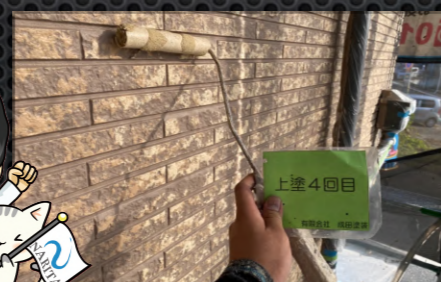
サイディングの塗装 再現工法
